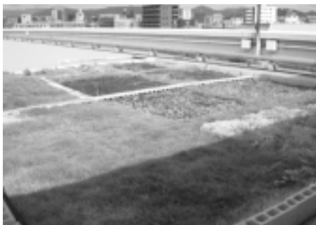
図6 屋上緑化プラント
