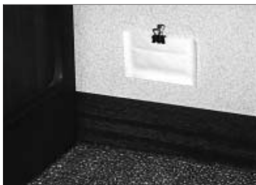
図3 壁面に設置した室内用カビセンサー
