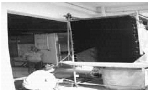
海水濃縮装置(2号機)
