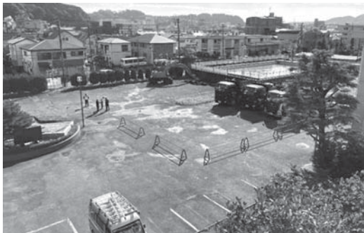
写真3 建設科実習棟建設予定地
