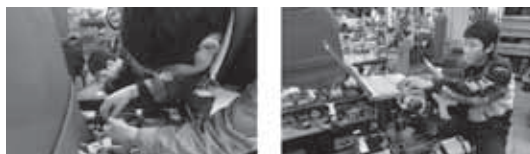
写真5 コントロール・ユニットの配線接続と制御データ変更の様子
