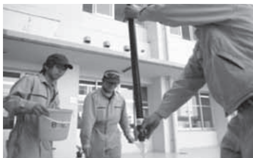
図 13 コックを開けた時の水力確認
