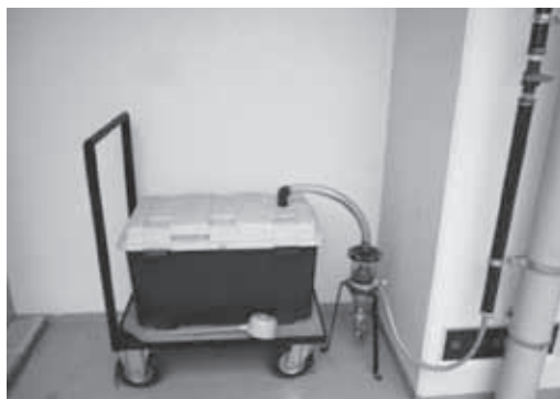
図 15 雨水回収システムの完成
