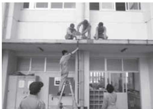
図 14 雨水回収システムの作動チェック
