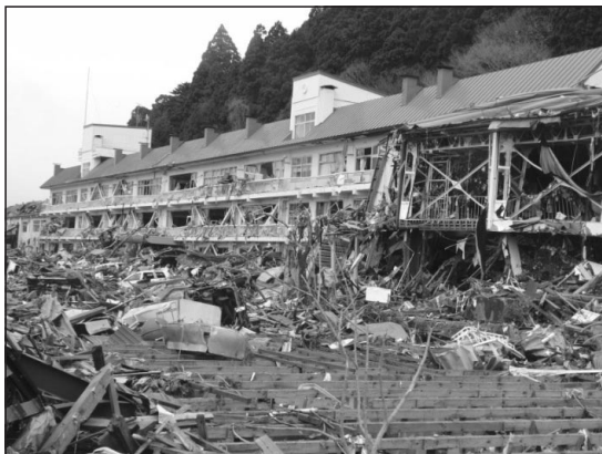
被災した本校舎 （手前は体育館だったがつぶされていた）
