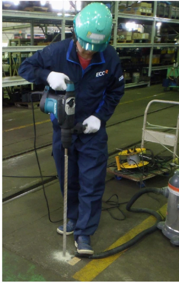
ドリルで削孔 (地表面がアスファルト等で舗装されている場合)
