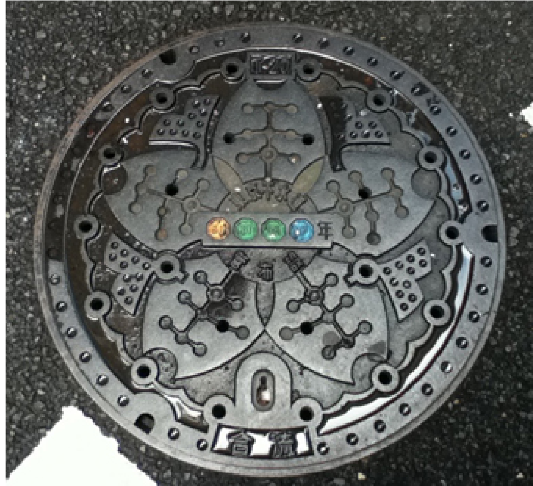
合流式下水管渠のマンホール (東京都, 神田)
