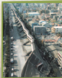
④阪神淡路大震災で倒壊した阪神高速道路 直下型地震におそわれた神戸市では多くの建築物が倒壊し、火災も発生して多くの犠牲者が出ました。
