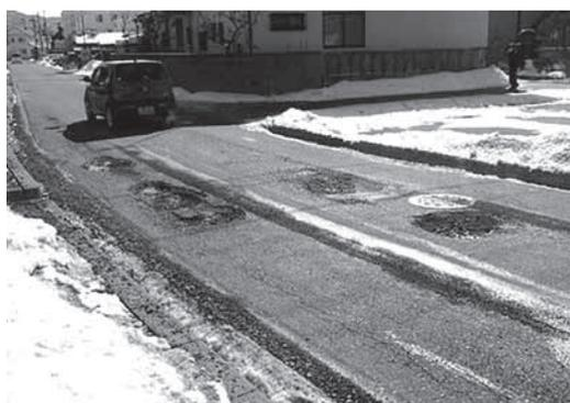
図1 凍害による劣化（盛岡市2018）
