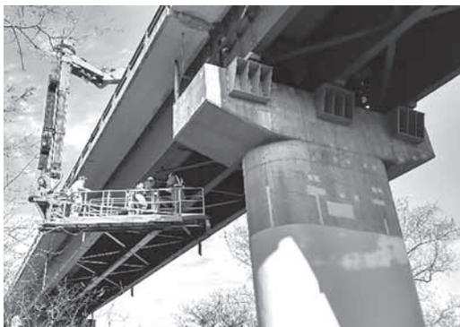
図5 橋梁点検車による目視点検
