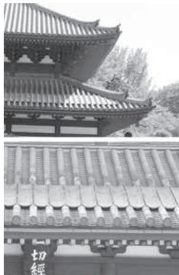
経堂は重層宝形造り、本瓦葺 上層からの雨垂れで下層屋根瓦を穿ってしまう対策として、雨垂れの落下位置に二重瓦として、交換可能な状態に葺いて工夫する先人の知恵であった。
